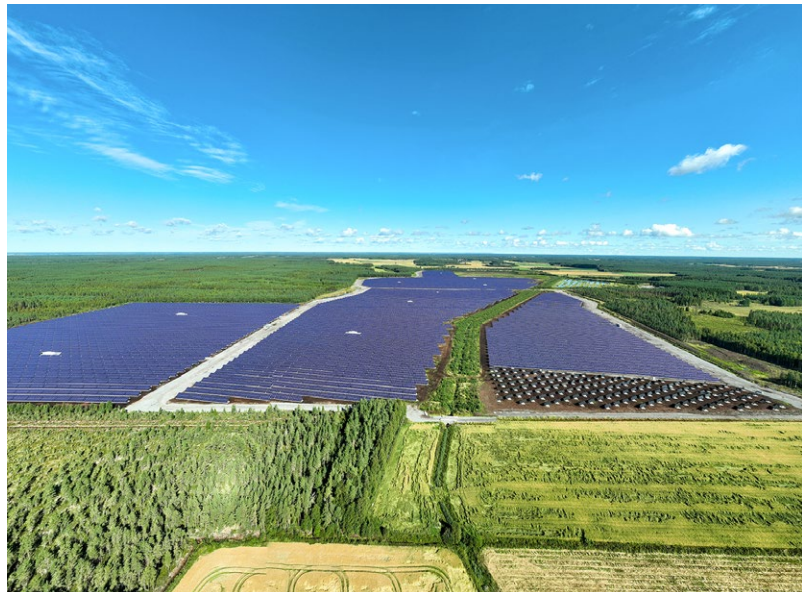
Kuva: EPV Energia Oy
