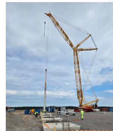
Ensimmäisen elementin asennus tehtaaseen 21.7.2025.
