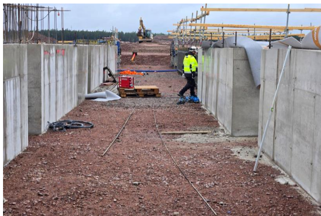
Perustuksien korkeudet ovat laitealueella huomattavia. Valettu määrä on noin 9.900 m 3
