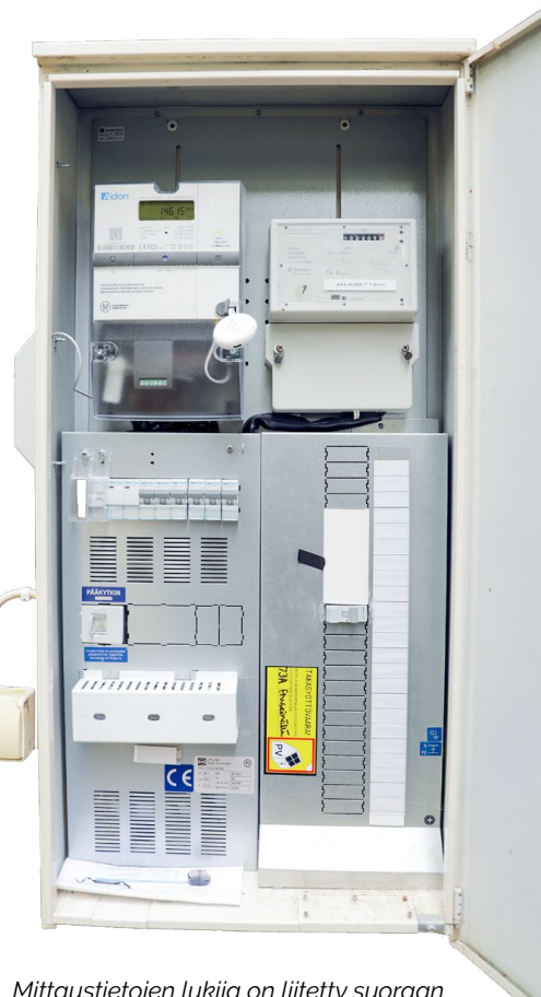
Mittaustietojen lukija on liitetty suoraan HAN-porttiin ja yhdistetty kodin WiFi-verkkoon.
