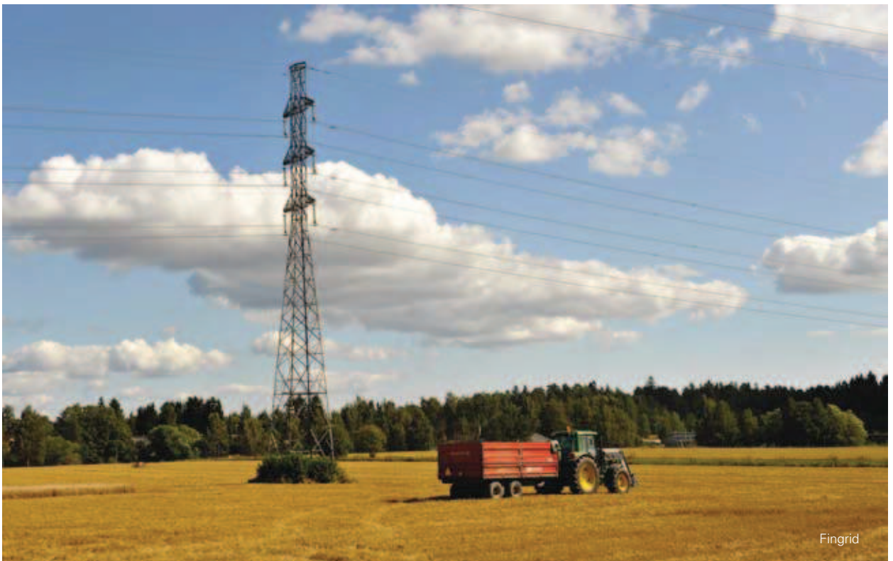
Voimajohdon alla olevia alueita voi käyttää laidunmaana ja niillä voi tehdä maataloustöitä. Korkeiden työkoneiden turvallisesta käytöstä kannattaa kysyä voimajohtoyhtiöltä.
